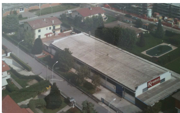
La copertura del capannone ospiterà l'impianto fotovoltaico di Kronos Compassi.
