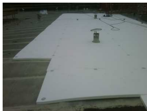
I lavori di posa della copertura
