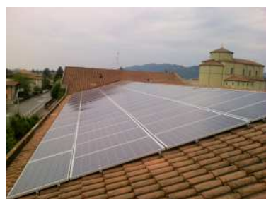
L'impianto da 19,8 kWp presso la Scuola media di Presezzo, i lavori di posa sono stati ultimati.
