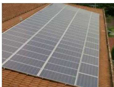
L'impianto da 19,8 kWp presso la Scuola media di Presezzo, i lavori di posa sono stati ultimati.
